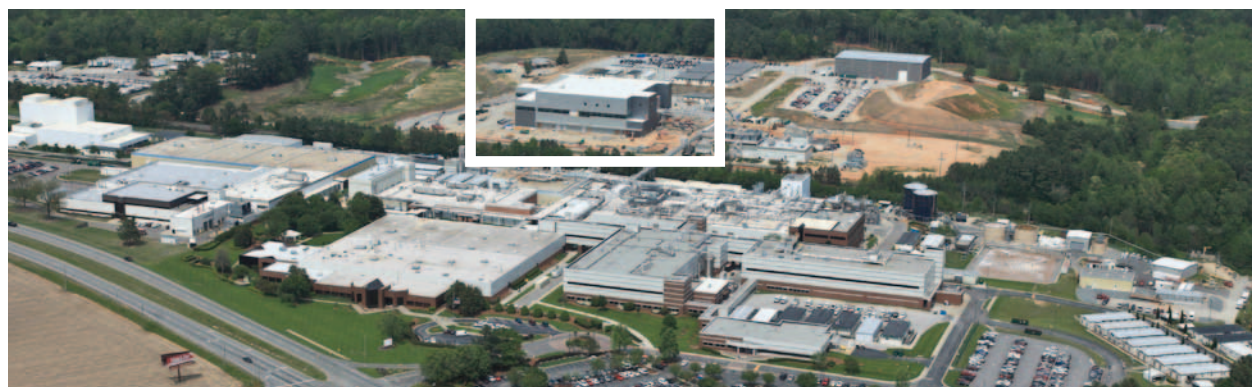
Vista aérea del polígono industrial de Grifols en Carolina del Norte (EEUU) con la nueva planta de fraccionamiento
